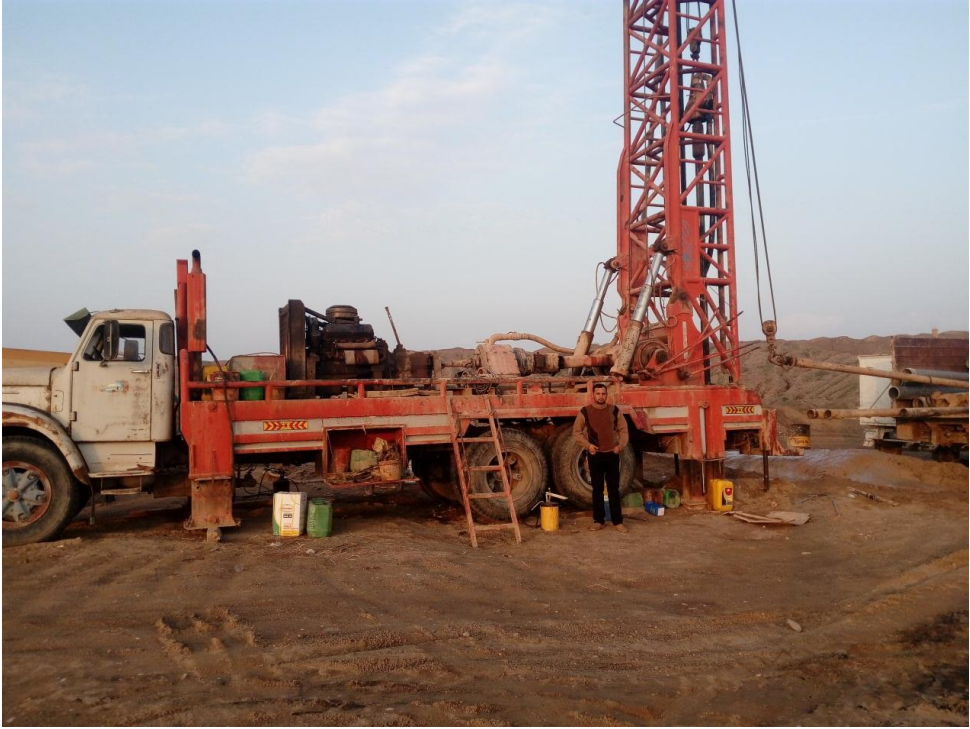
صورة (٣) عمليات حفر احد الابار الارتوازية في مقالع جلات
